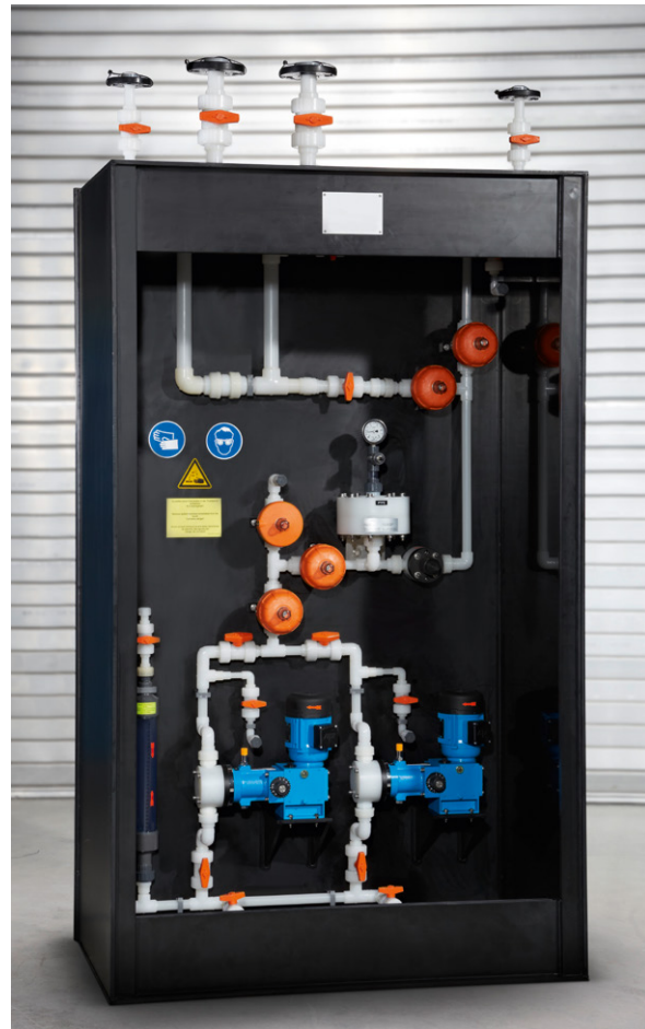
Abb. 4: Dosierstation für Schwefelsäure zum Einsatz im Kraftwerksbereich
