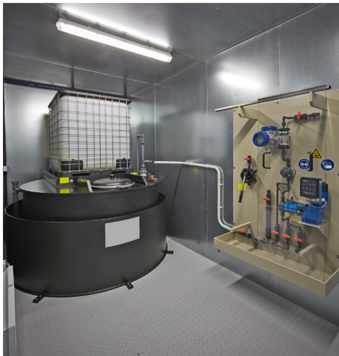
Abb. 5: In einen Container mit Kolben-Membran-Dosierpumpe eingebauter Mutterbehälter
