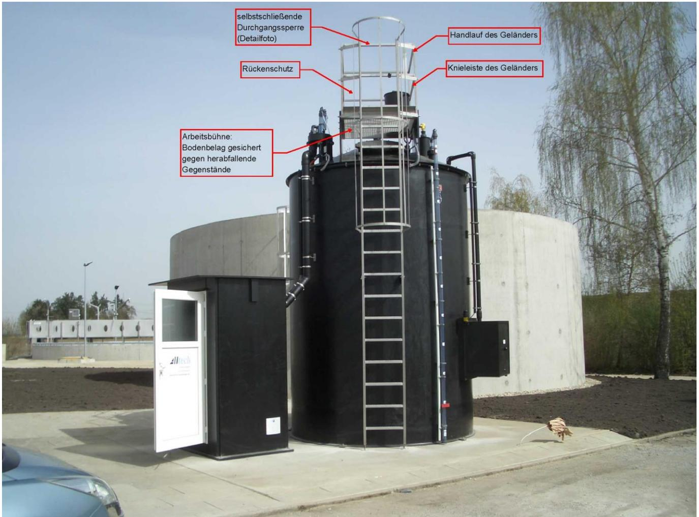
**Abb. 1: Phosphatfällungsanlage Alltech, mit sicherheitsrelevanter Ausstattung nach DIN EN ISO 14122**
