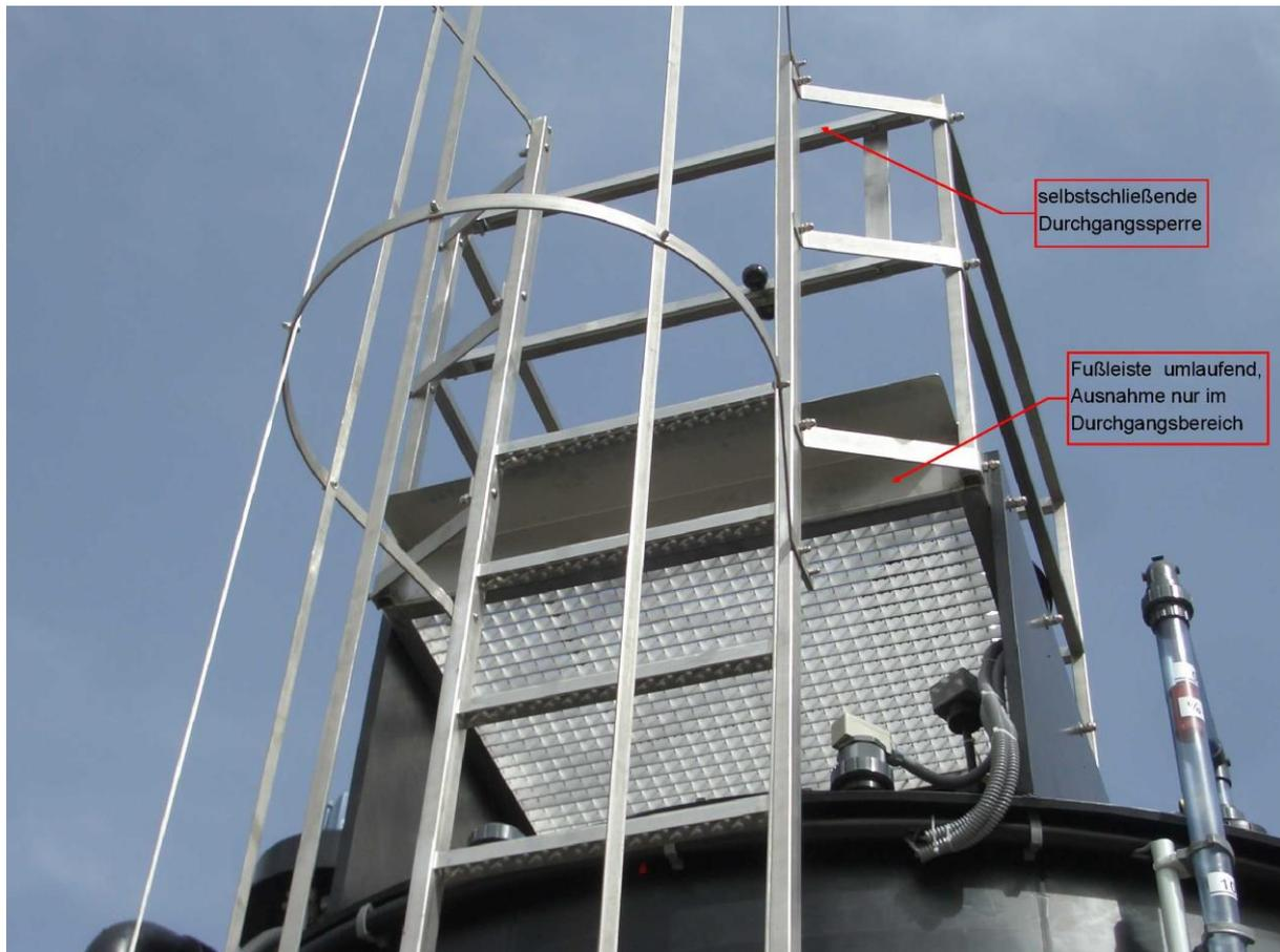
**Abb. 2: Phosphatfällungsanlage Alltech (Detail), mit sicherheitsrelevanter Ausstattung**
